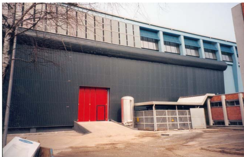
Figur 4: eksempel på anvendelse af den Canadiske Solvæg på forskningscentret ISPRA i Italien.
